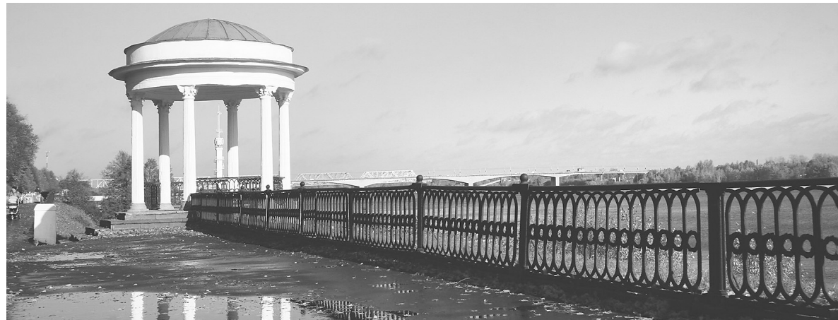
↓ На укрепление берега и благоустройство набережной император выделил из казны 200 тысяч рублей.
