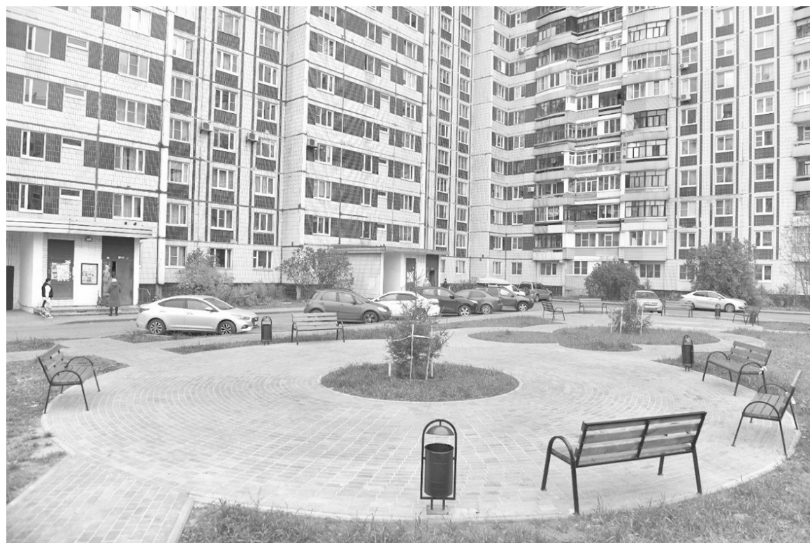
↓ По губернаторскому проекту «Наши дворы» выполнен ремонт двора на Ленинградском проспекте.
