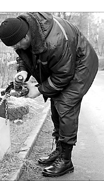
Идет демонтаж незаконных конструкций.
